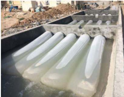
شکل ۹- ساختار فیلتراسیون چندلایه در مزارع پرورش میگو
