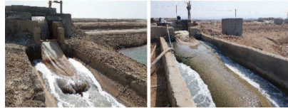
شکل ۶- تصویر استفاده از فیلتراسیون یک‌لایه در مزارع پرورش میگو که توصیه نمی‌گردد.
